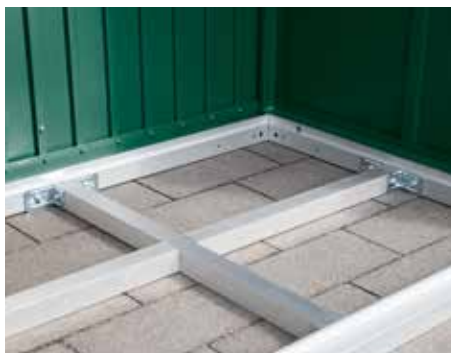
Stalen onderconstructie voor vloeren
