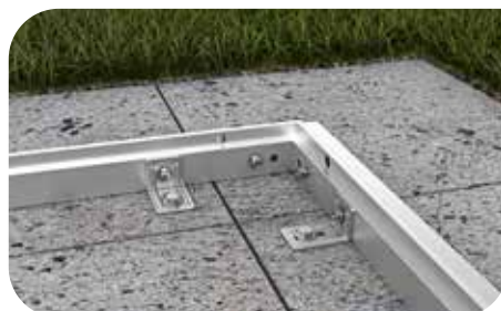
Met de bijgeleverde hoekprofielen-set (16 stuks) en schroeven aan de ondergrond bevestigen.
