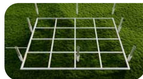
Lijn eerst de 4 buitenste grondankers aan het vloerframe uit en vervolgens de overige grondankers plaatsen. Een inschroefhulp is standaard bij de levering inbegrepen.
