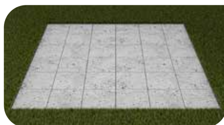
Leg de stenen platen en lijn uit met een waterpas.
